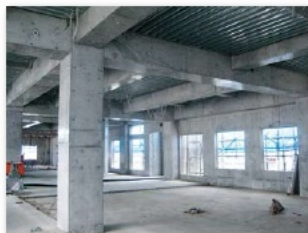
■1階総合ロビー・医事課付近内部工事
