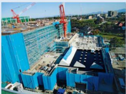
■本館南側外観
