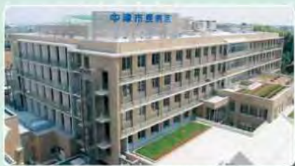
■本館西側外観(屋上緑化も進んでいます)
